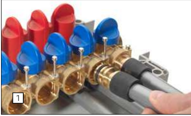
Şek. 6 Bağlama elemanının hızlı kavrama ile uygulanması
